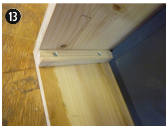
Tasseau renforcement dessous du bac 3.
