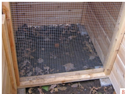
Installation du grillage
