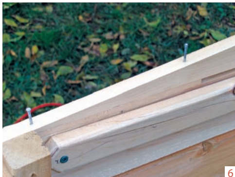
Partie avant de la planche coupée en diagonale et clouée sur la dernière planche à travers le petit bloc de bois
