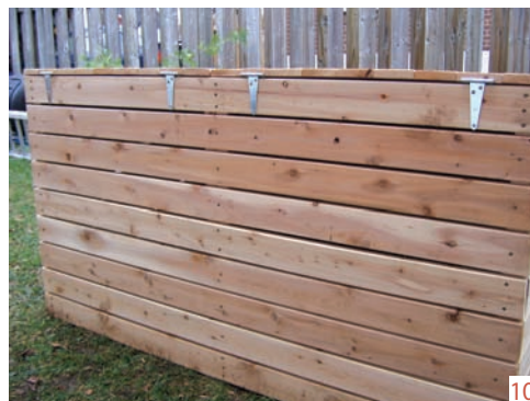
Installation des charnières
